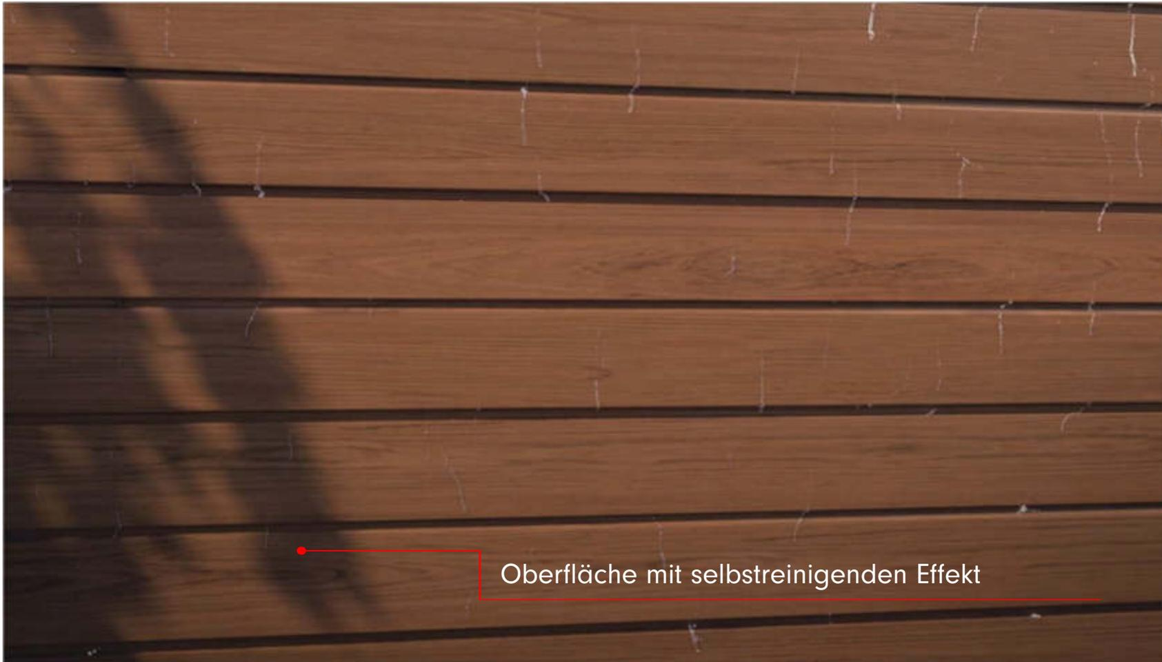
Oberfläche mit selbstreinigenden Effekt
