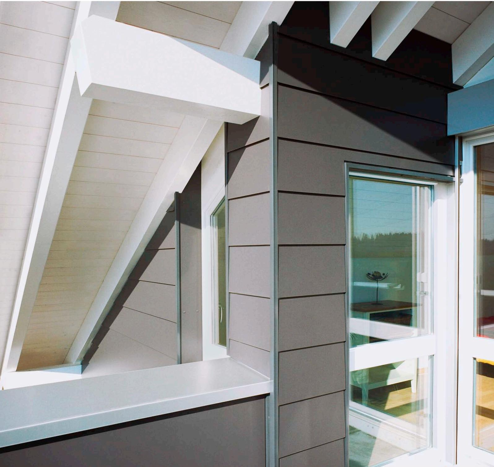
Kantenprofile ohne Schnittkantenüberdeckung
