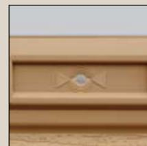
Zentriertes Nagelloch zur Fixierung der Fassadenpaneele.
