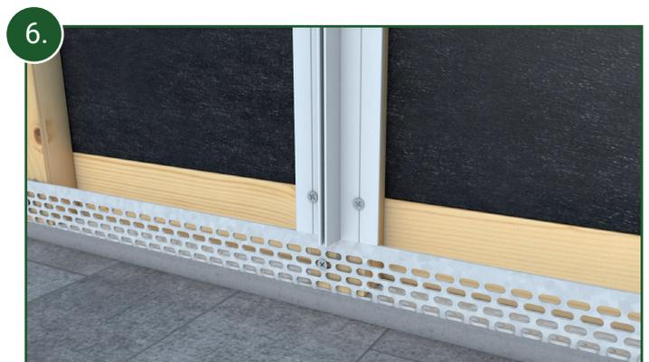
6. Verfahren Sie ebenso mit den Unterteilen der Verbindungsprofile, wenn ein längsseitiger Stoß der Fassadenprofile erforderlich ist. Die Positionierung der Verbindungsprofile erfolgt mittig auf den Traglatten. Der Abstand zum oberen Fassadenende muss 60 mm betragen.
