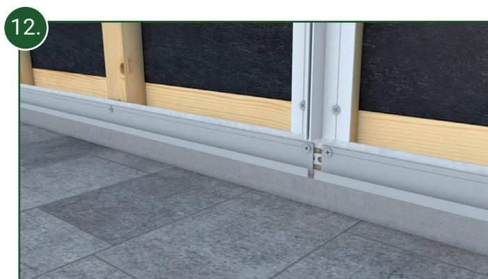
12. Fixieren Sie das Aluminium-Startprofil nun bündig mit der Unterkante des unteren Lüftungsprofils entlang des unteren Fassadenabschlusses mit Hilfe der eingebrachten Schraubnut. Achtung: Im Bereich der Verbindungsprofile müssen die Startprofile geteilt werden!
