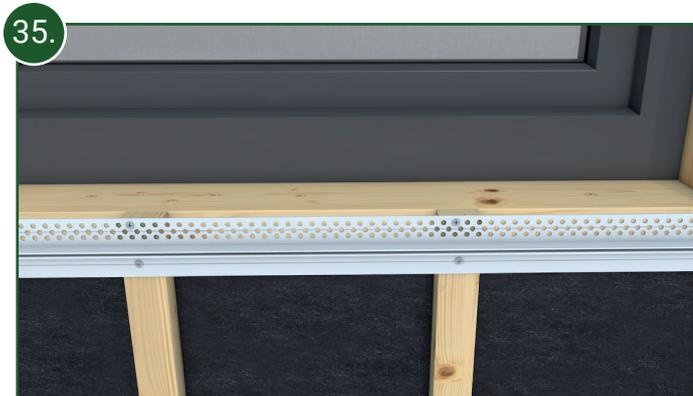
35. An der Unterseite der Fensterbank verschrauben Sie ein Unterteil des 2-teiligen, oberen Lüftungsprofils, damit auch in diesem Bereich eine Entlüftung gewährleistet ist.
