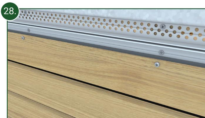
28. Anschließend wird das Fassadenprofil mit den Fassadenschrauben entsprechend fixiert.
