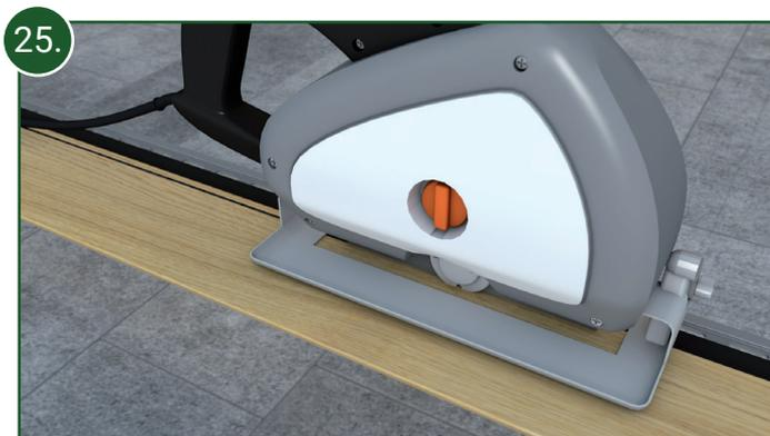
25. Die Kürzung kann problemlos mit Hilfe einer Stichsäge oder Handkreissäge erfolgen.
