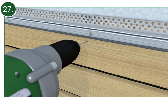
27. Das gekürzte, obere Fassadenprofil wird ca. 10 mm unterhalb der Sägekante im Abstand von 30 cm auf Höhe der Traglatten vorgebohrt.
