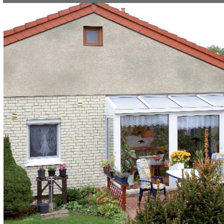
Vor der Renovierung mit vinyPlus DRP
